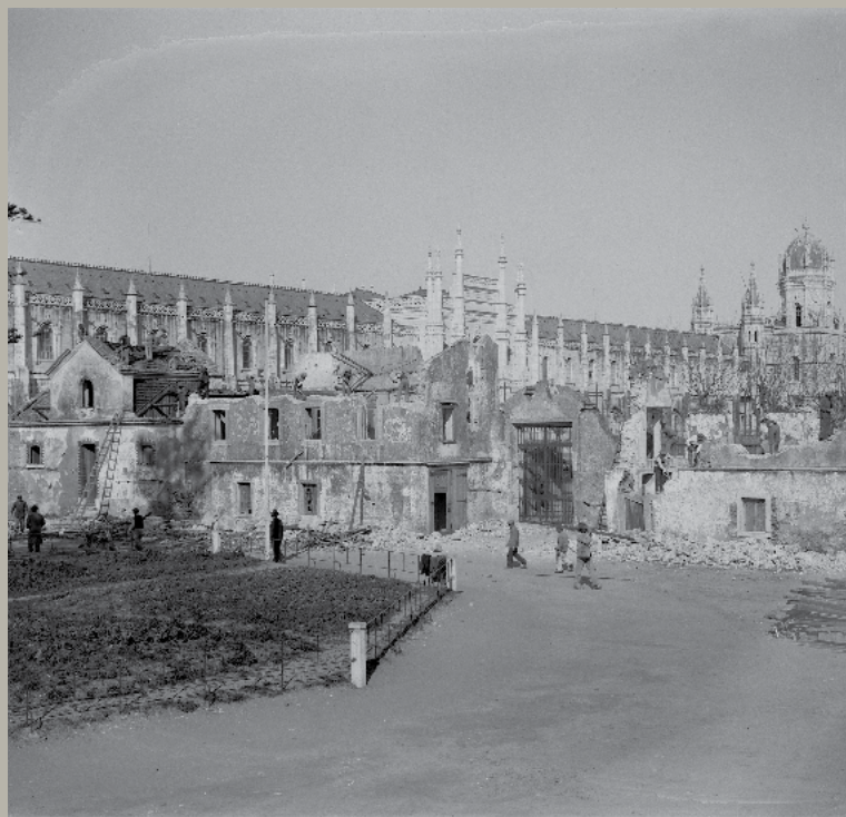
Trabalhos preparatórios para a construção da Exposição do Mundo Português, ant. 1940. CFT164.2653.ia Col. Estúdio Horácio Novais I FCG - Biblioteca de Arte e Arquivos
